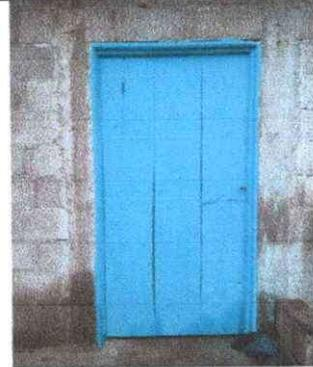
Foto 2: Cambio de puerta de madera por metal en el area de la cocina
