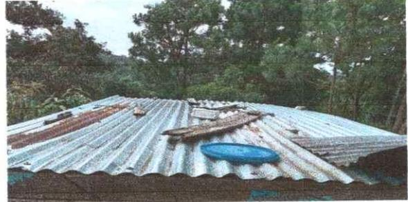
Foto 2: cambios de laminas de cocina por laminas troqueladas
