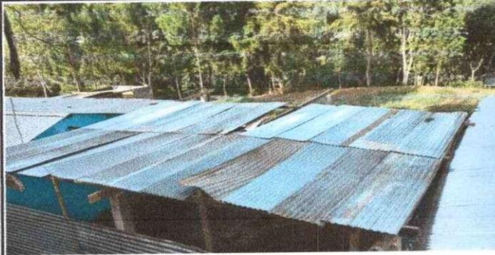
Foto1: cambios de laminas por laminas troqueladas
